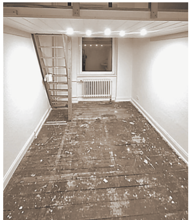
Zimmer Falkenburg nach den Maler-, aber noch vor den Fußbodenarbeiten. Foto: Tänzler
